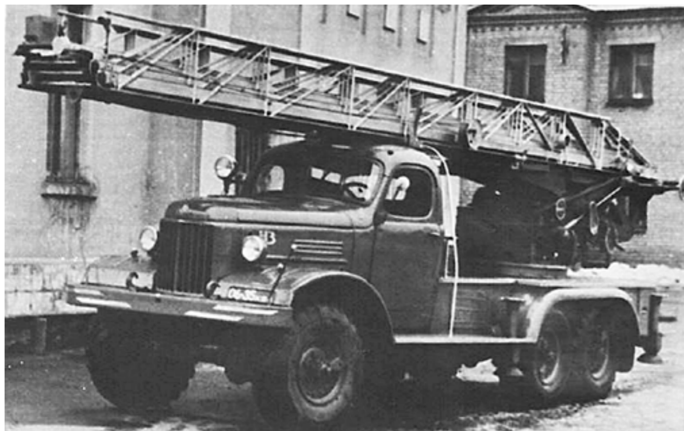
Автомеханическая лестница АЛМ -30/157 (модель ЛР), 1960-е годы
