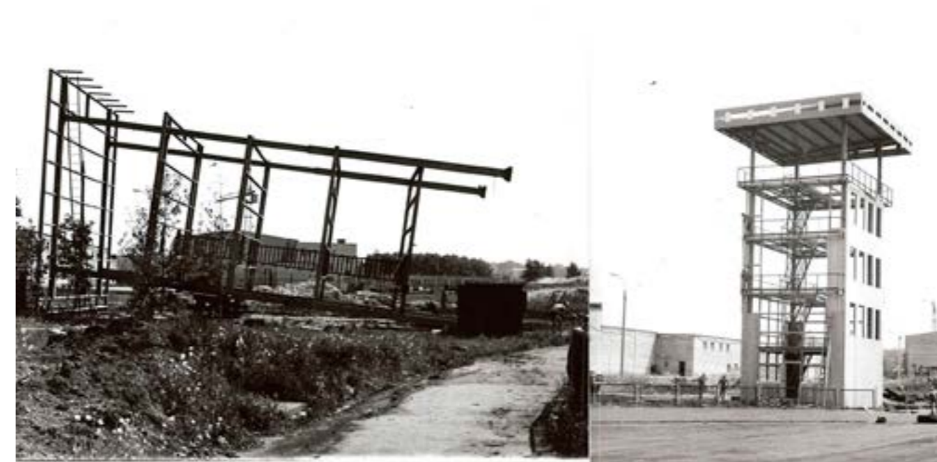
Строительство учебной башни на стадионе «Прометей», г. Киров, 1989 год
